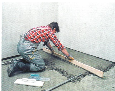
Rys. 3.26. Wyrównywanie za pomocą łąty
