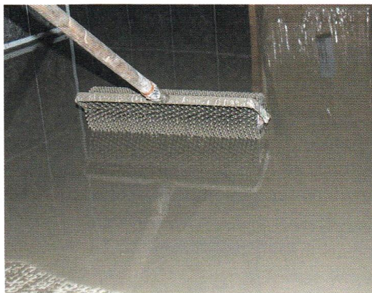
Rys. 3.32. Odpowietrzanie za pomocą wałka kolczaka
