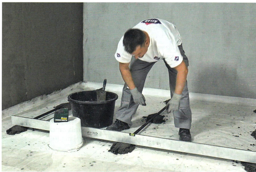
Rys. 3.24. Wypoziomowanie listew prowadzących
