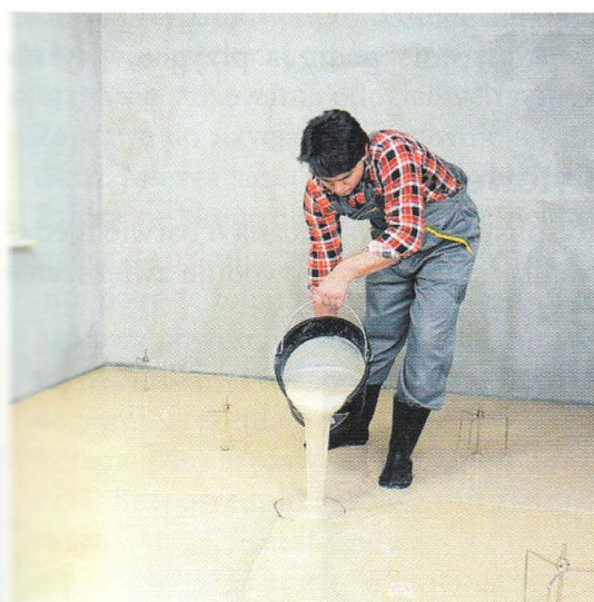
Rys. 3.29. Ręczne wylanie podkładu samopoziomującego
