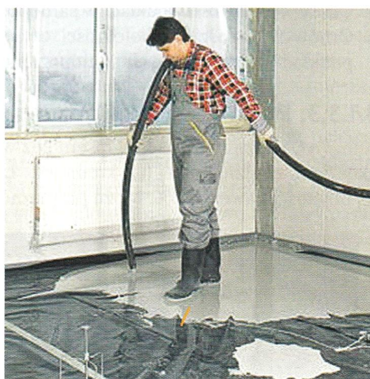
Rys. 3.30. Maszynowe wylanie podkładu samopoziomującego
