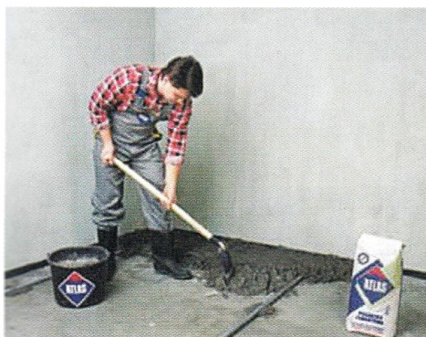
Rys. 3.25. Rozkładanie zaprawy
