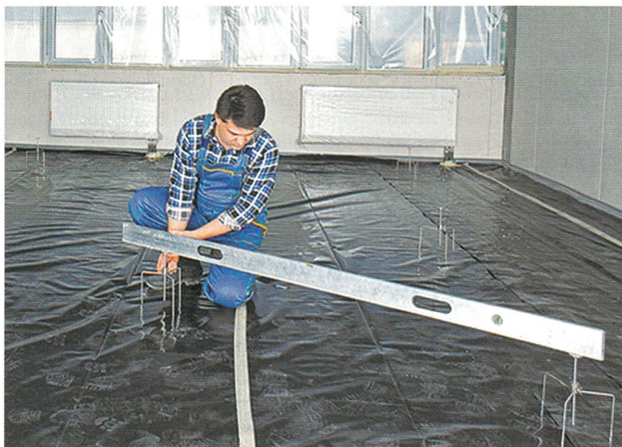
Rys. 3.28. Określanie poziomu powierzchni przyszłego podkładu za pomocą długiej poziomnicy i przenośnych reperów wysokościowych
