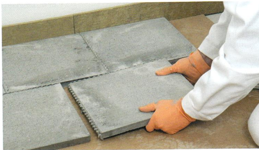
Rys. 3.35. Ciężki podkład z płyt betonowych
