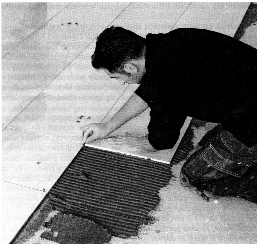
Rys. 3.15. Jedna z faz układania płytek na posadzce: przyklejanie płytek przy użyciu krzyżyków dystansowych
