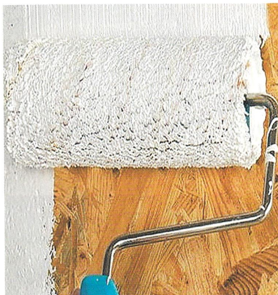
Rys. 4.82. Nanoszenie preparatu powierzchniowego w postaci emulsji gruntującej
