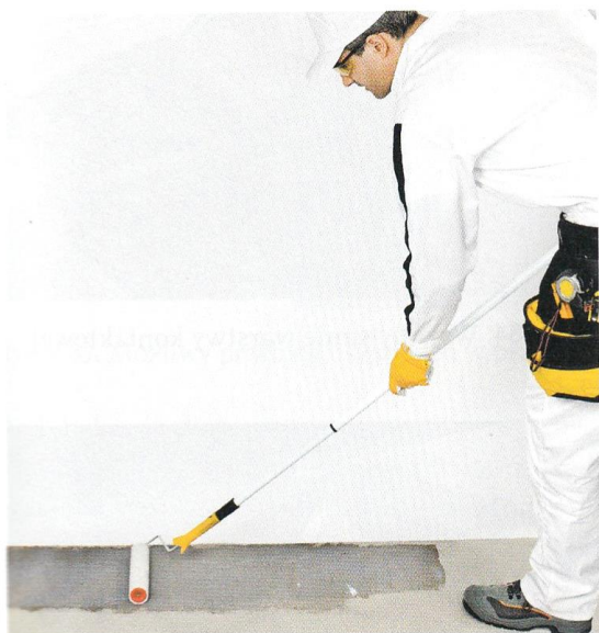
Rys. 4.81. Nanoszenie preparatu wgłębnego zwiększającego przyczepność
