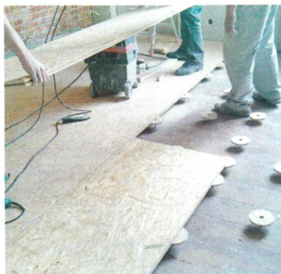
Rys. 4.80. Montaż płyty na podłożu
