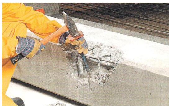
Rys. 4.83. Przygotowywanie podłoża
