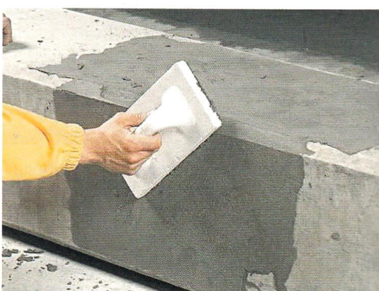
Rys. 4.86. Wygladzanie powierzchni
