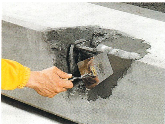
Rys. 4.85. Wykonywanie głównej warstwy naprawczej
