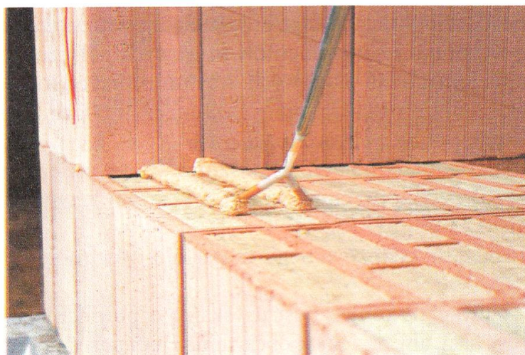
Rys. 4.83. Łączenie pustaków na poliuretanową zaprawę w piance
