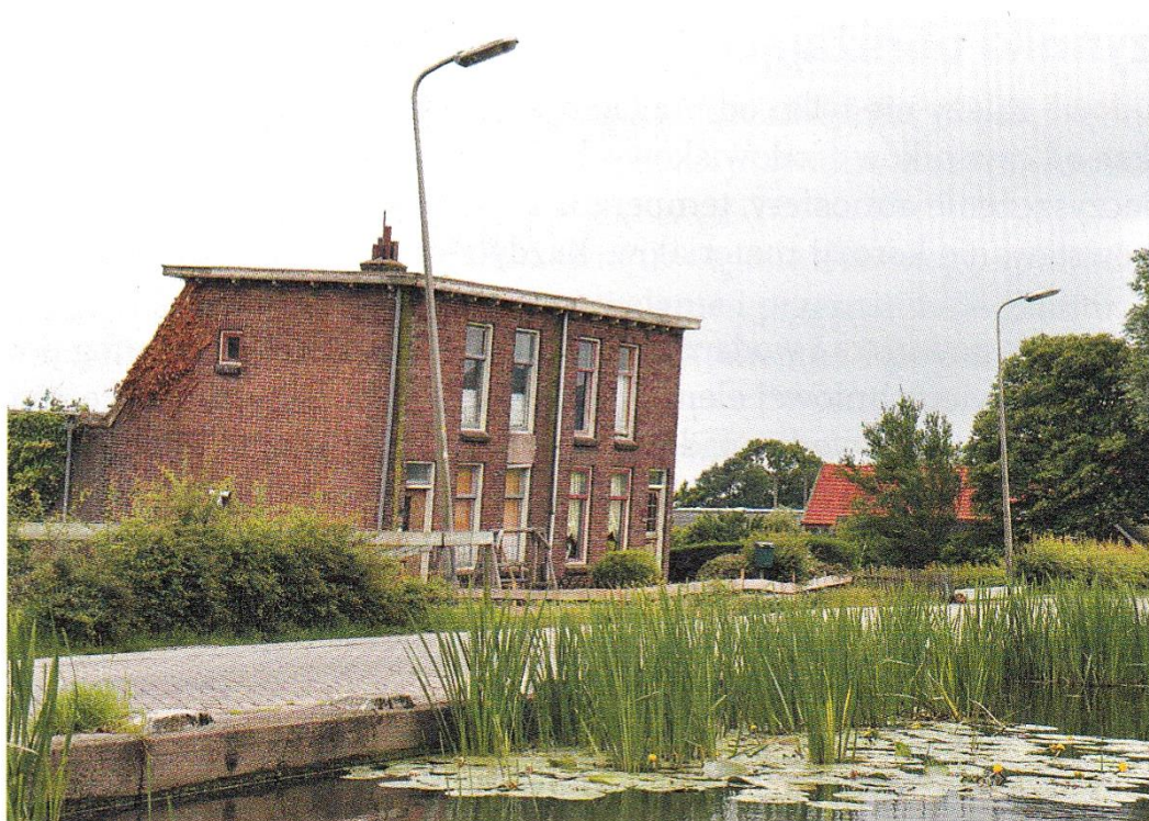
Rys. 5.3. Nierównomierne osiadanie budynku wskutek ruchu wód gruntowych
