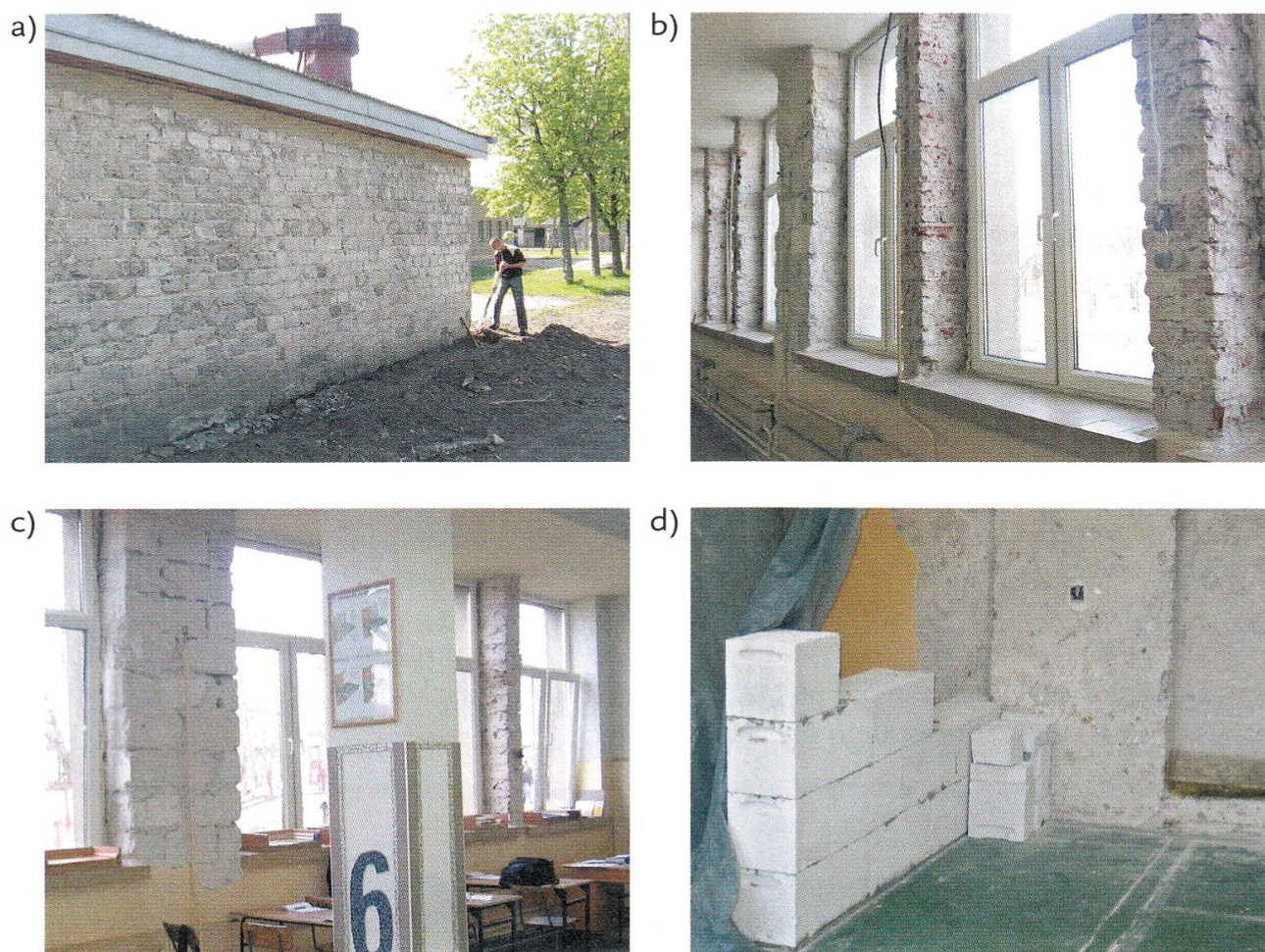
Rys. 5.11. Uszkodzenia elementów wykończeniowych wymagające naprawy: a) ściana zewnętrzna, b) słupki ceglane przy ościeżach, c) ściana wykonana z bloczków, d) ściana z bloczków domurowywana do ściany konstrukcyjnej
