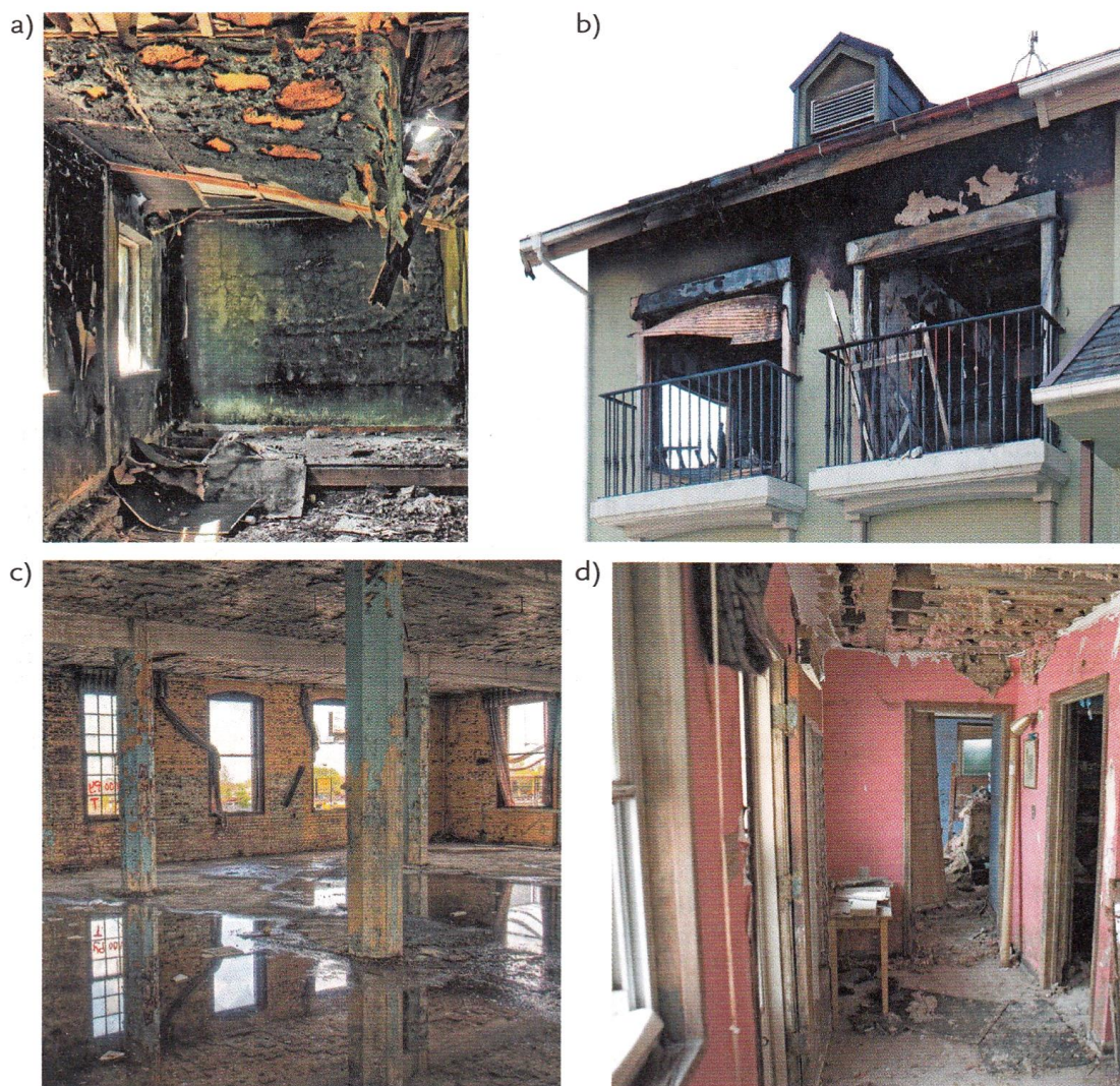
Rys. 5.1. Budynki wymagające kapitalnych remontów: a) wnętrze budynku po pożarze, b) budynek po pożarze – widok z zewnątrz, c) wnętrze magazynu po powodzi, d) wnętrze budynku mieszkalnego po powodzi
