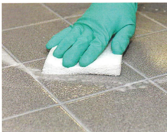
Rys. 4.24. Usuwanie nalotu z fugi epoksydowej
