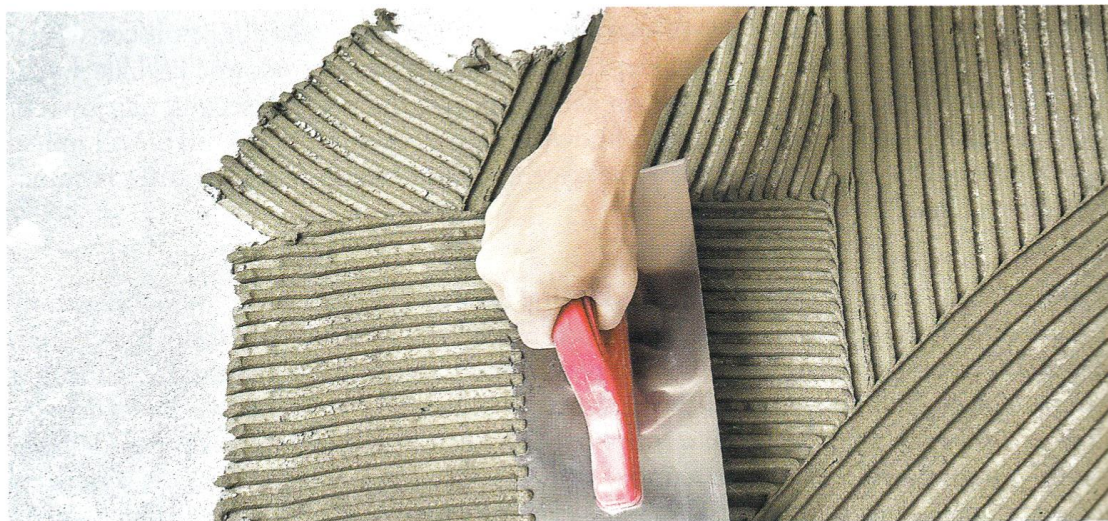
Rys. 4.95. Metoda rozprowadzania kleju na podłożu za pomocą pacy grzebieniowej
