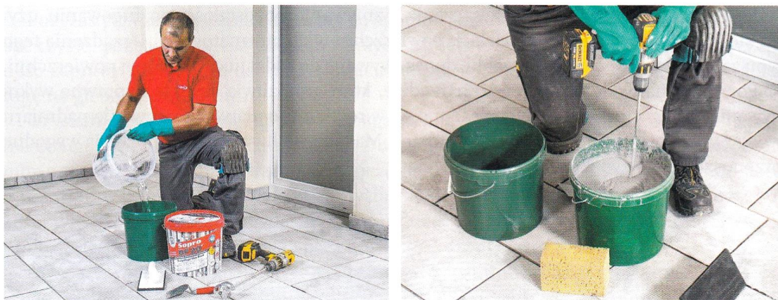
Rys. 4.18. Przygotowywanie zaprawy do spoinowania
