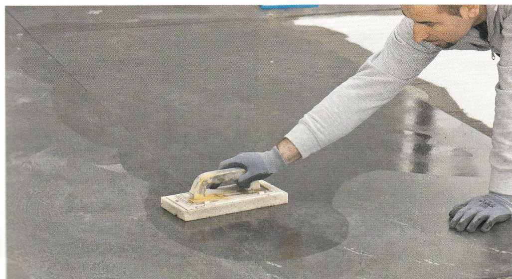
4.98. Etap montażu płyt wielkoformatowych ze spieków kwarcowych
