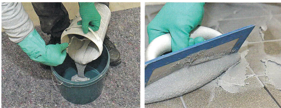
Rys. 4.22. Rozprowadzanie zaprawy epoksydowej do spoinowania
