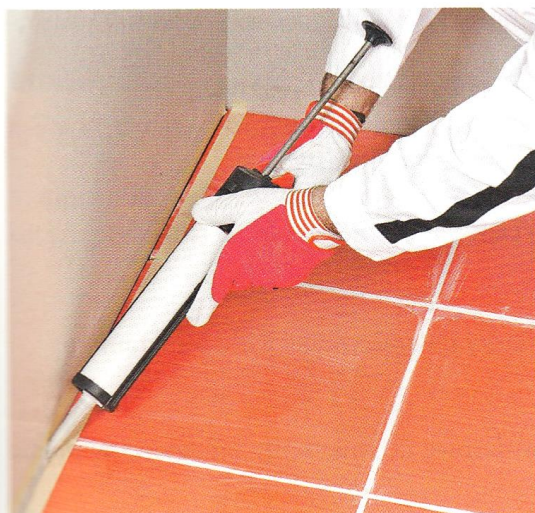
Rys. 4.28. Proces wypełniania i kształtowanie fugi silikonowej
