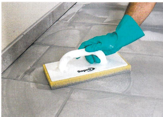
Rys. 4.20. Wstępne oczyszczanie powierzchni z nadmiaru zaprawy do spoinowania
