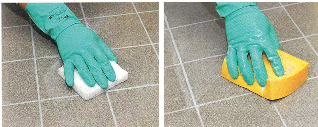
Rys. 4.23. Czyszczenie powierzchni płytek padem i gąbką wiskozową
