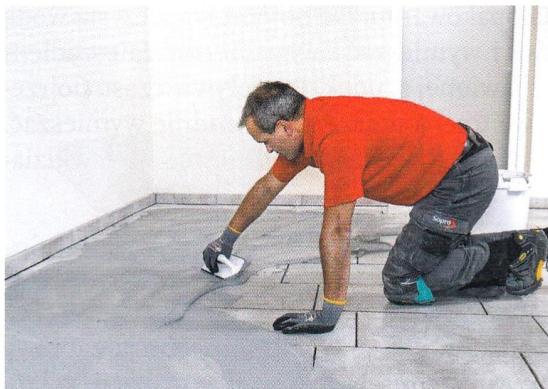
Rys. 4.19. Rozprowadzanie zaprawy fugowej
