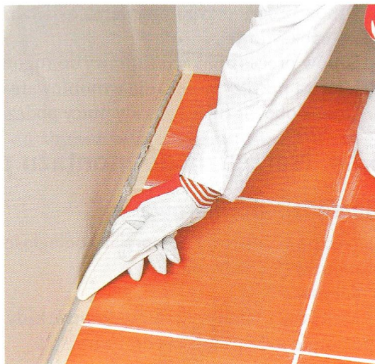
Rys. 4.27. Kostki i szpachelki do ściągania nadmiaru fugi silikonowej
