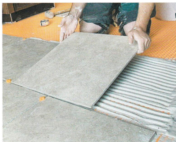
Rys. 4.100. Montaż okładziny ceramicznej
