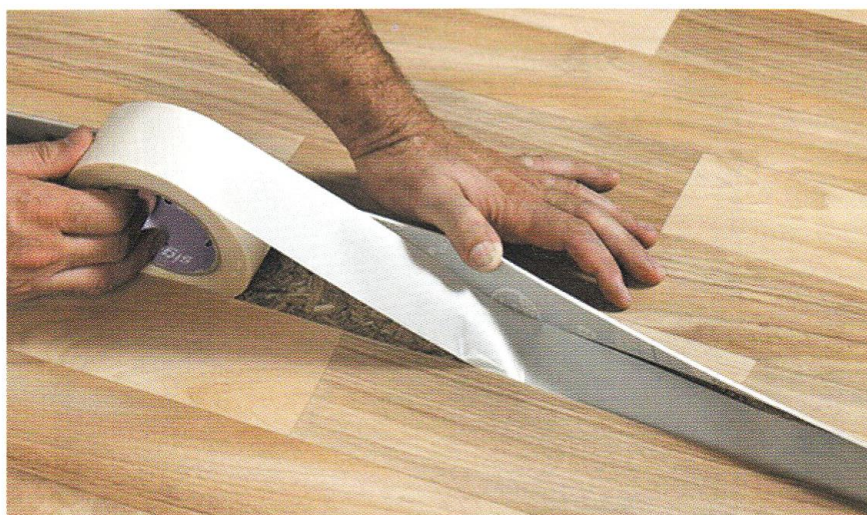
Rys. 6.62. Łączenie dwóch pasm wykładziny w obrębie spoiny za pomocą taśmy dwustronnej
