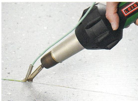
Rys. 6.58. Spawanie spawarką ręczną
