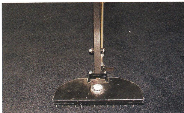
Rys. 6.71. Dociskanie wykładziny w okolicy spoiny kolczastą rolką
