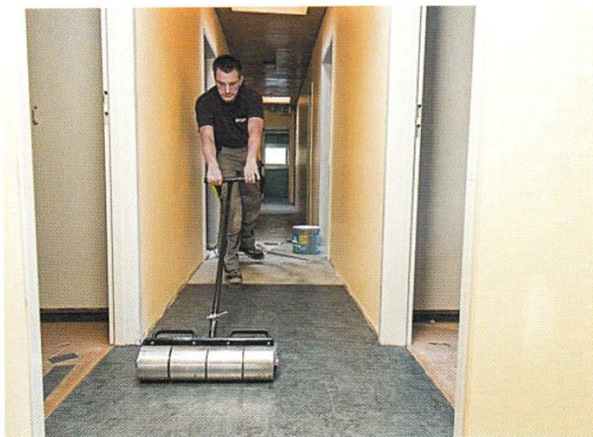
Rys. 6.64. Dociskanie wykładziny – walcowanie
