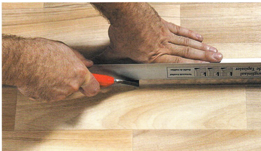
Rys. 6.61. Wyrównywanie krawędzi wykładziny do spawu na zimno
