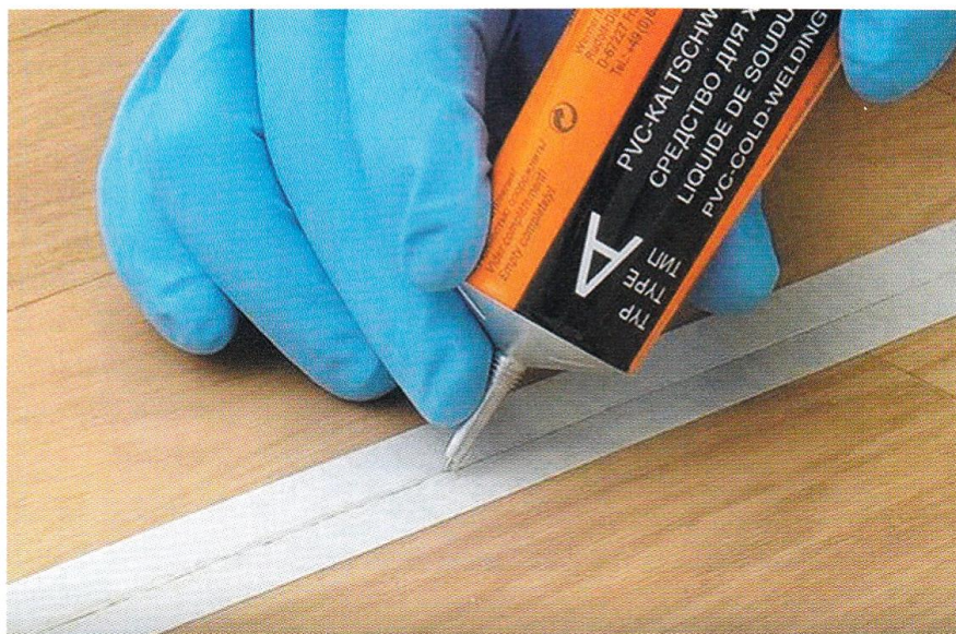
Rys. 6.63. Aplikacja kleju w miejscu przecięcia taśmy papierowej
