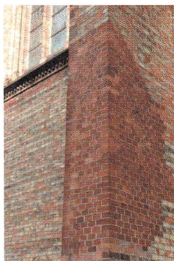
Rys. 5.29. Usuwanie uszkodzeń i wzmacnianie muru przez: a) przemurowanie częściowe, b) wymianę odcinka muru
