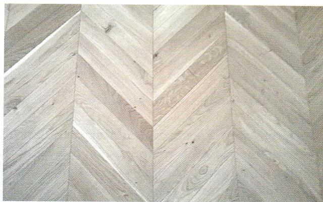
Rys. 5.58. Przykład posadzki z deszczulek w układzie w jodełkę francuską
