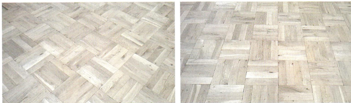
Rys. 5.61. Przykład posadzki w układzie deszczulek w szachownicę – przed cyklinowaniem
