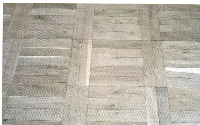
Rys. 5.59. Przykład posadzki z deszczulek w układzie w drabinkę – przed cyklizowaniem
