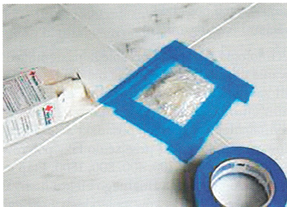
Rys. 4.115. Usuwanie plam z płytki kamiennej
