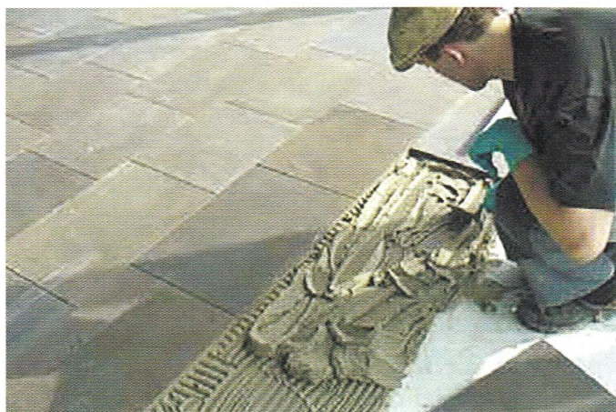
Rys. 4.114. Układanie kamienia naturalnego metodą średniowarstwową na zaprawie
