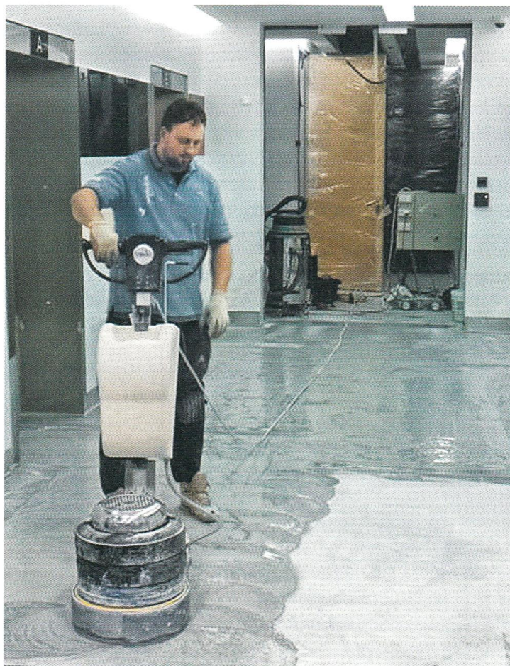
Rys. 4.116. Szlifowanie posadzki z kamienia naturalnego
