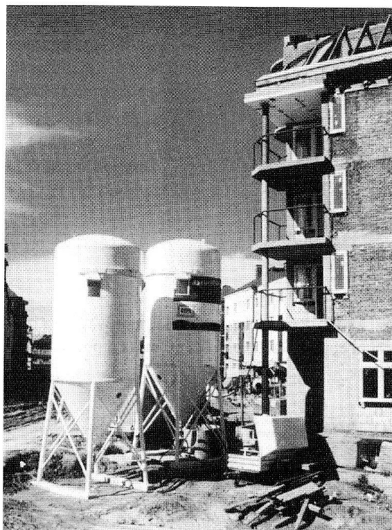
Rys. 21.18. Widok placu budowy z silosami na suchą mieszankę gipsową
