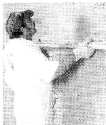
Rys. 21.20. Bezpośrednio po wykonaniu narzutu należy przystąpić do ściągania i wyrównywania narzutu za pomocą łaty aluminiowej H
