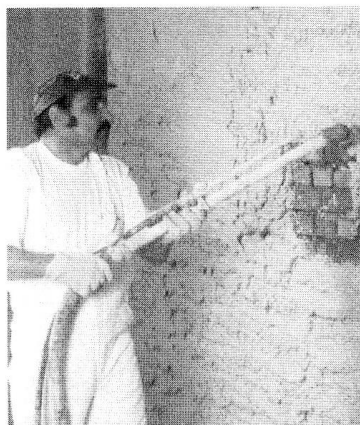
Rys. 21.19. Końcówkę tynkarską należy prowadzić ruchem ciągłym w odległości 50 mm od powierzchni podłoża
